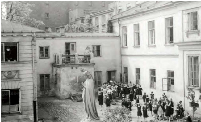
Dom główny sióstr Rodziny Maryi w Warszawie przy ul. Żelaznej
